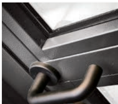
Folha predisposta para vidro, em caixilho tubulado.
